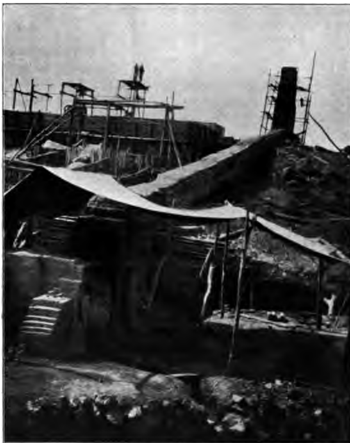
FIGURE 12. — ESSAIS MÉTALLURGIQUES DU CUIVRE. — FOURS A RÉDUCTION SANS FUSION DE LA GANGUE.
